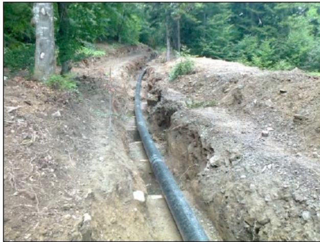
**Figure 12** : New buried conduit
